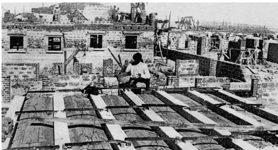
4. Bovedillas fabricadas in situ. Fuente: Reconstrucción . Dirección general de regiones devastadas y reparaciones, Ministerio de la Gobernación 1940-1953
