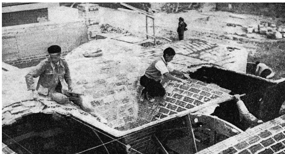
5. Construcción de bóvedas tabicadas en Villanueva de la Cañada (Madrid). Fuente: Catálogo de la Exposición “Villanueva de la Cañada. Historia de una reconstrucción. Centro Cultural La Despernada, 11 de junio al 6 de octubre de 2001”. Excmo. Ayuntamiento de Villanueva de la Cañada, 2001
