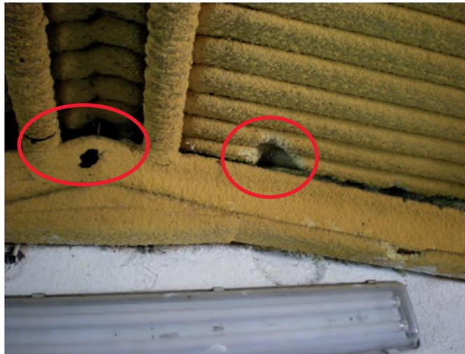
Figura 1. Las ratas roen cualquier tipo de material (en el ejemplo aislante del techo de una nave ganadera)
