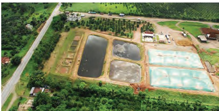
Figura 9. Sistemas de depuración biológica por oxidación
