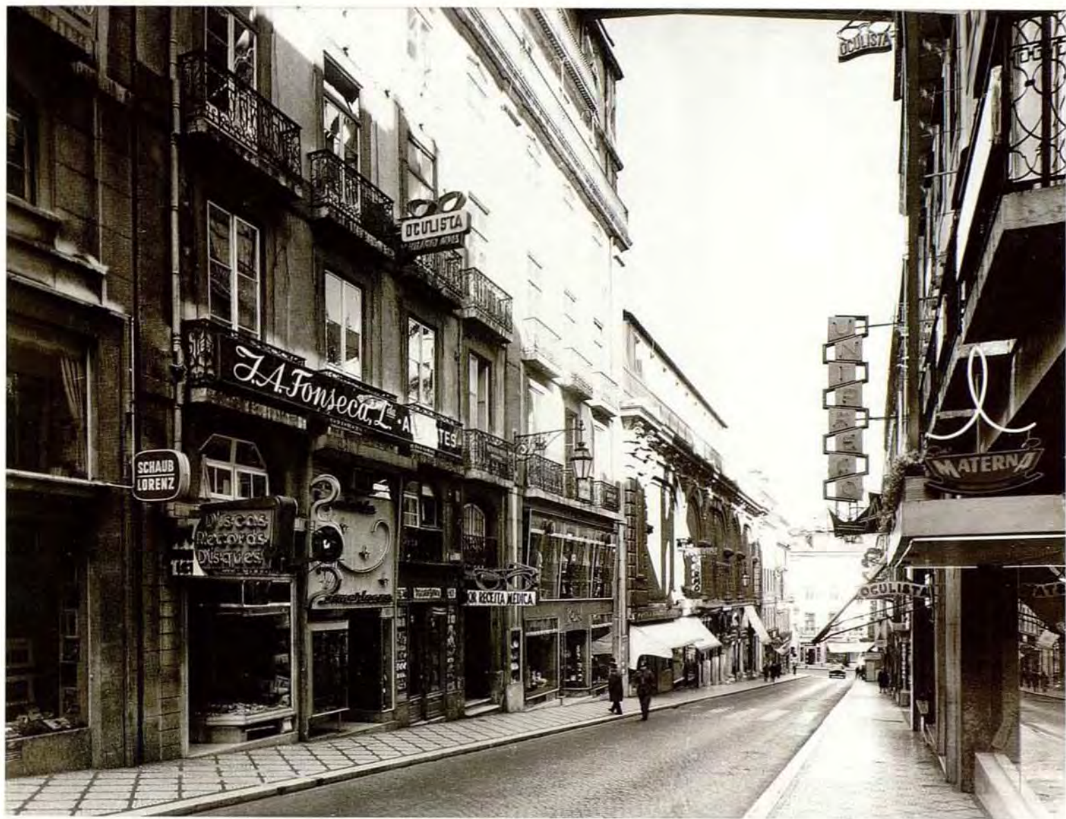
Vista de la Rua do Carmo bajo la pasarela de Santa Justa.
