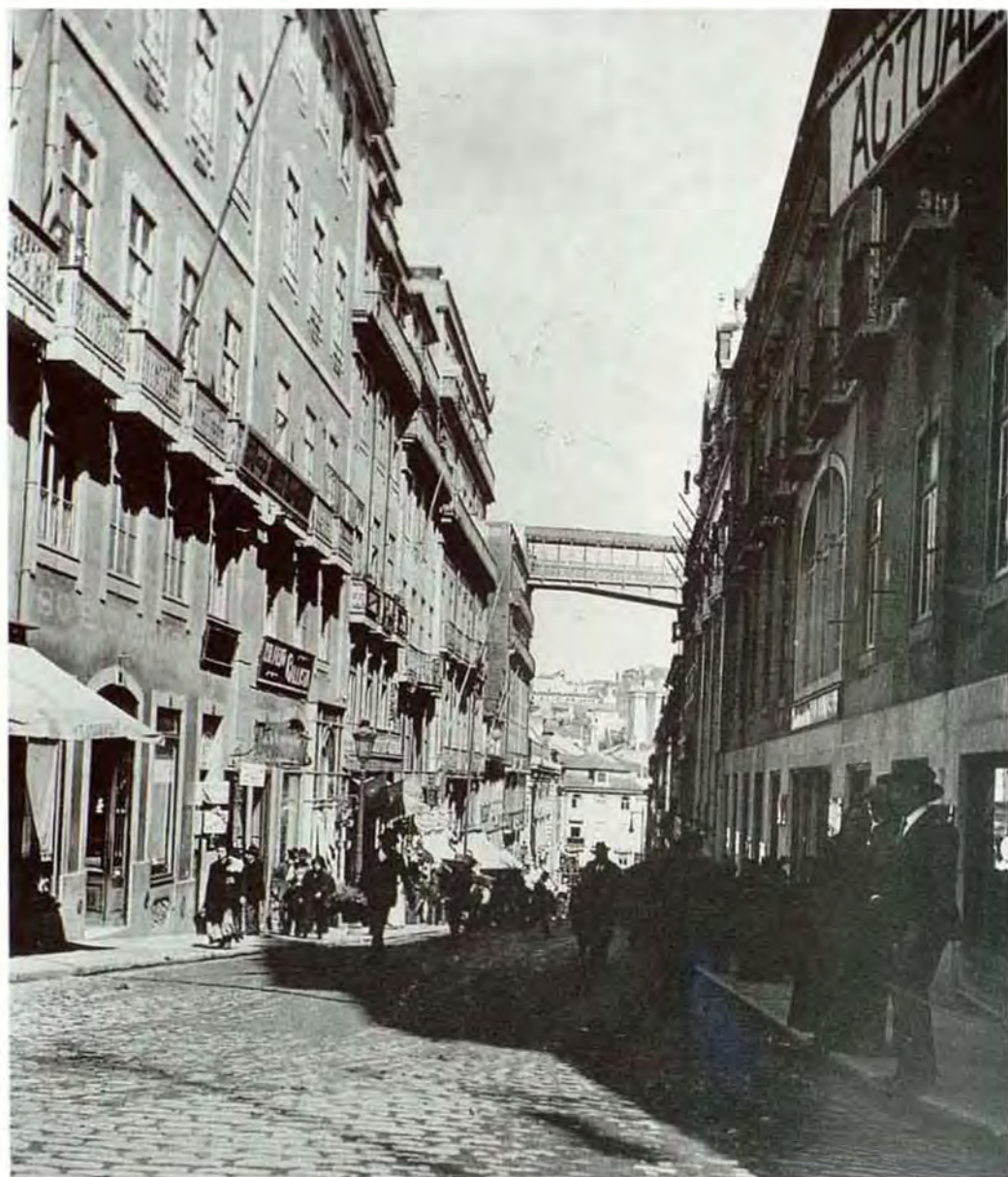
Pasarela sobre la Rua do Carmo.
