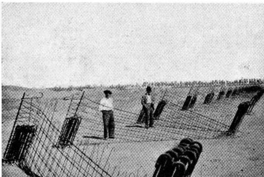
Armaduras para el anclaje de la superestructura del gran hangar de dirigibles, cuya cimentación está ya construída.
