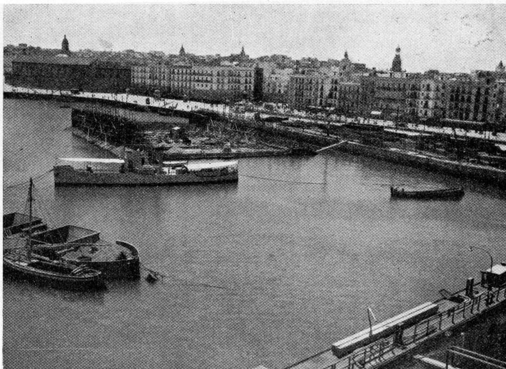
Fig. 7.<sup>a</sup> Vista de los cuatro primeros cajones, ya soldados los tres primeros y el cuarto rigidamente unido con ellos y preparado para hormigonar la soldadura. En los frentes del cuarto cajón se ven las bordas provisionales para asegurar la estabilidad, y la situación de las vigas de alteada
