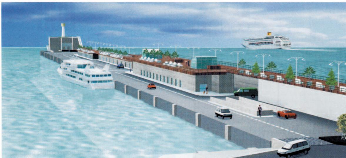
El funcionamiento del dique en lo que respecta a rebases de oleaje es muy eficaz. De hecho, para alturas de la ola de hasta 6 m, la agitación en la dársena del antepuerto es prácticamente nula, con períodos de oleaje inferiores a 8 s en el sector ESE, e inferiores a 10 s en el sector SE.
