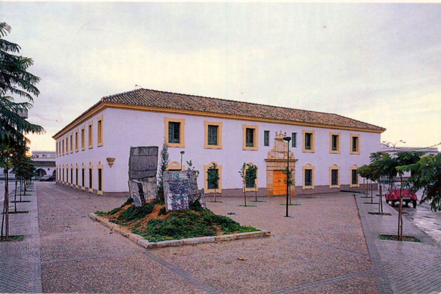
Fachada y espacio posterior tras la rehabilitación
