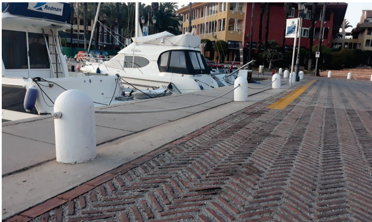
Zona junto al cantil, a modificar eliminando las sogas entre bolardos.
