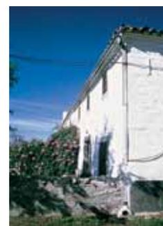
El núcleo principal se estructura alrededor de un amplio patio con viviendas, pajar y establos. La pieza más destacada es una vivienda de dos plantas con muros de mampostería y cubierta de teja a cuatro aguas, mientras la mayor parte de la actividad productiva se desarrolla en naves de reciente construcción con estructura metálica y cubierta de chapa. A pesar de su denominación, no hay restos de lagar en el conjunto de los edificios ni de viñedo en los contornos.
