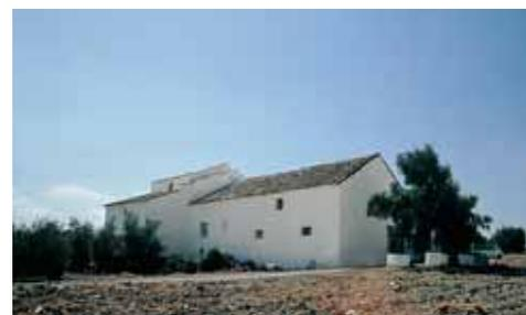
en obra de mampostería y tapial y cubiertas de teja curva. Del conjunto destaca por su volumen la nave de la almazara, con la torre de contrapeso apenas resaltada sobre los faldones de la cubierta a dos aguas. Tanto el molino –habilitado para pajar y cochera– como las demás construcciones denotan reformas y ampliaciones, si bien en la actualidad la mayor parte del caserío está en precario estado de conservación.
