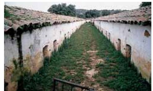
patio. Las piezas tienen bóvedas de cañón de escasa altura –1,6 m aproximadamente– y luz –apenas 1 m– y se cubren con teja, siendo la obra de mampostería y ladrillo. El conjunto se completa con la casilla del porquero, de una planta bajo tejado.
