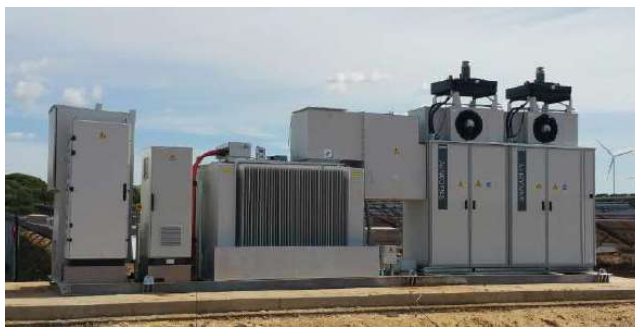
Figura 20. Ejemplo de centro de potencia de exterior Fuente Siemens
