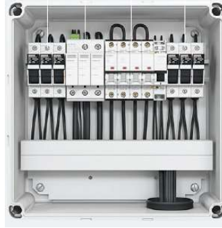
Figura 16. Ejemplo de caja de agrupación de strings Fuente: Siemens
