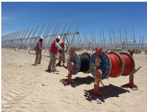
Imagen 9. Tendido de Cables Eléctricos
