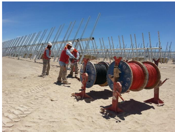
Imagen 9. Tendido de Cables Eléctricos
