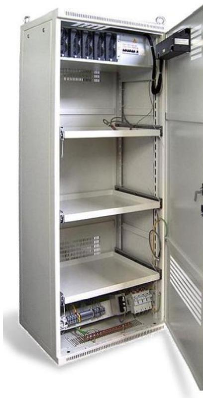
Ilustración 20. Rectificador RAF Argos ubicado en armario.
