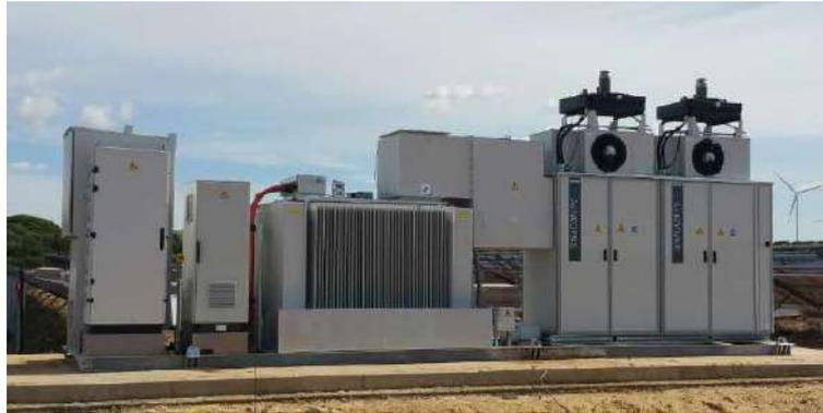
**Figura 20.** Ejemplo de centro de potencia de exterior Fuente Siemens
