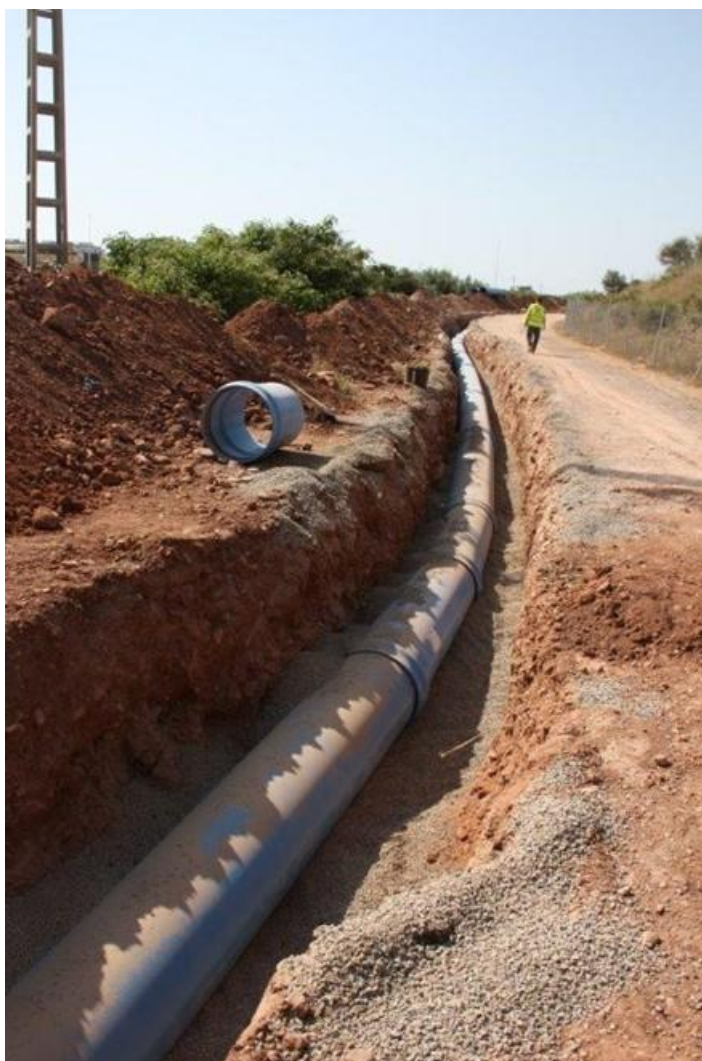
Figura 3.6 Ejemplo de tramo de tubería enterrada
