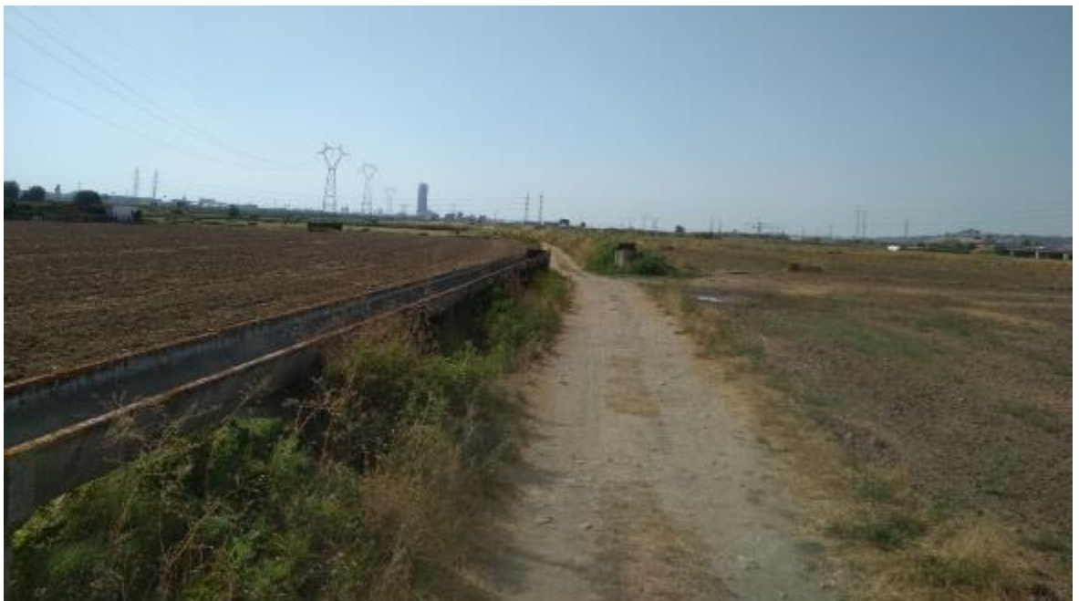
Figura 5.8 Terrenos dominados por arenas y limos cuaternarios característicos del valle aluvial del Guadalquivir, en el extremo este del trazado de la conducción
