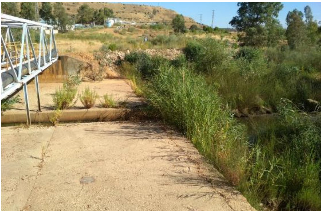
Figura 5.26 Cauce del río Crispinejo en el primer punto de cruce con la infraestructura proyectada
