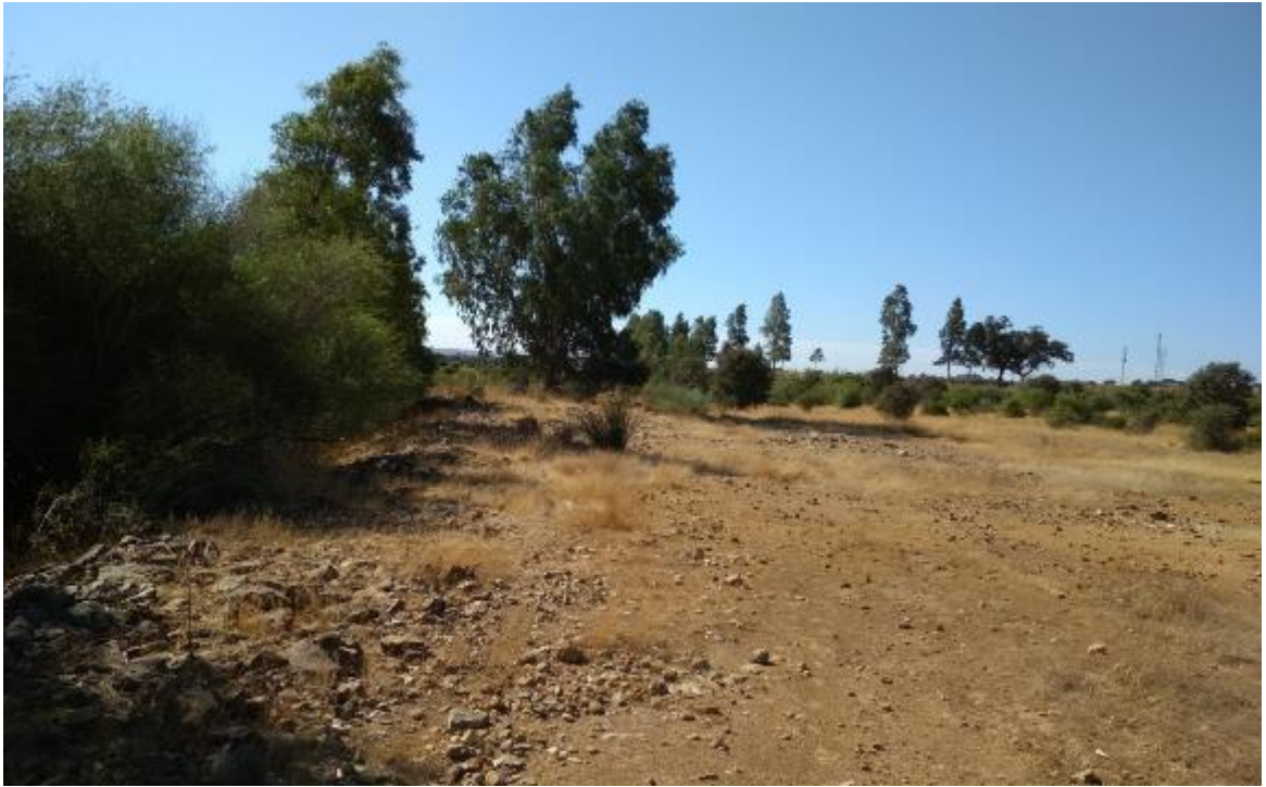
Figura 5.10 El cauce del río Crispinejo entre la actual PTA y el lugar de cruce se encuentra alterado por la presencia de una mota lateral que impide el desbordamiento del río, modificando su morfología natural
