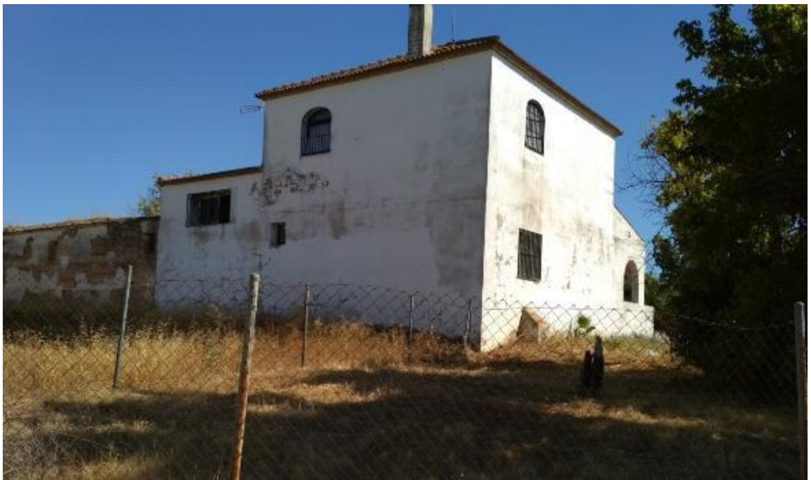
Figura 5.4 Cortijo innominado situado junto al cauce del río Guadamar (p.k. 7+480)
