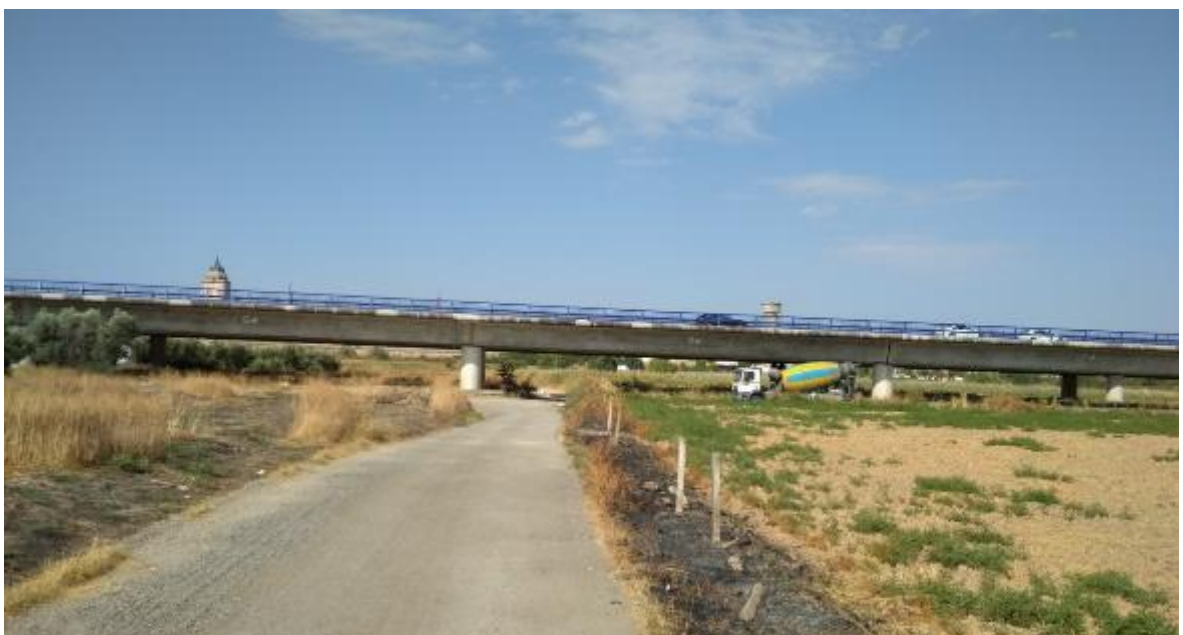
Figura 5.47 La segunda parte del recorrido del trazado entra en una zona dominada por los cultivos de regadío, entre los cuales discurren numerosas vías de comunicación de gran capacidad (p.k. 26+060)
