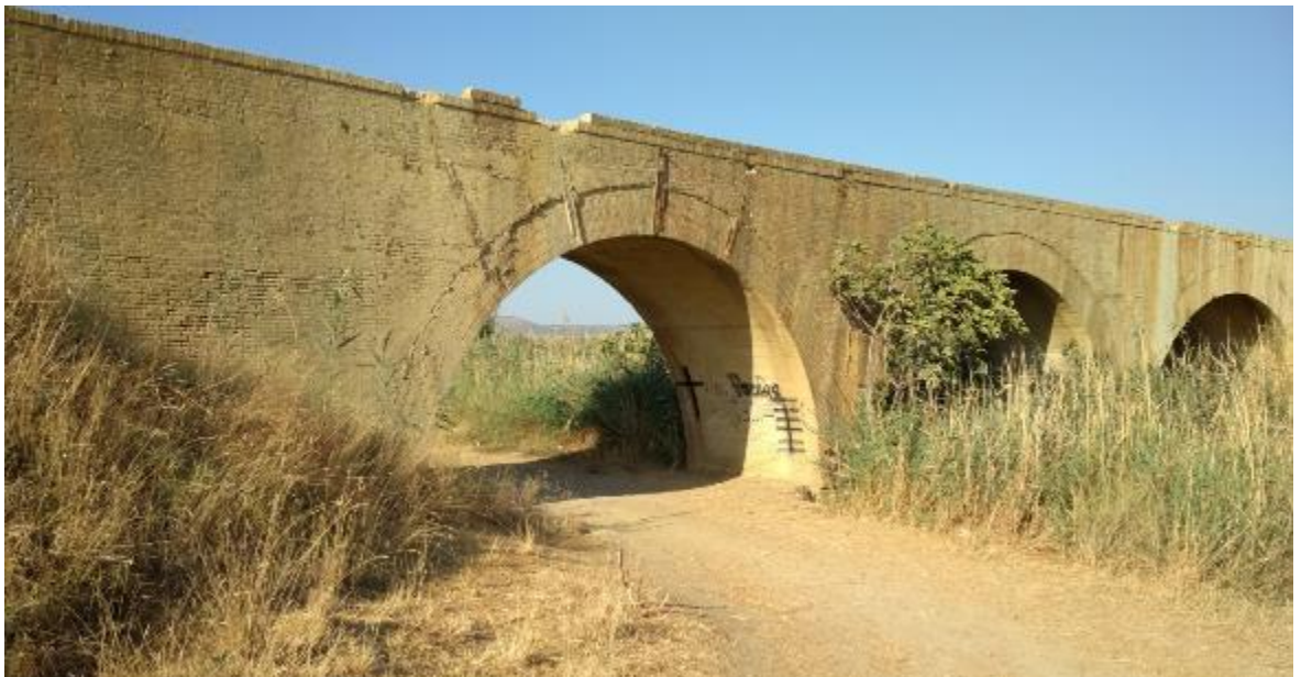
Figura 5.85 Cañada Real de Medellín a la Isla Mayor, coincidente con el arroyo Pie de Palo y el merendero situado junto a la vía antigua del ferrocarril, en el municipio de Valencina de la Concepción. P.k. 18+860
