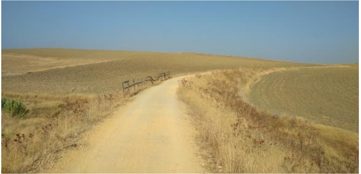
Figura 5.7 Materiales miocénicos con presencia de margas, dominantes en la mayor parte del recorrido de la conducción
