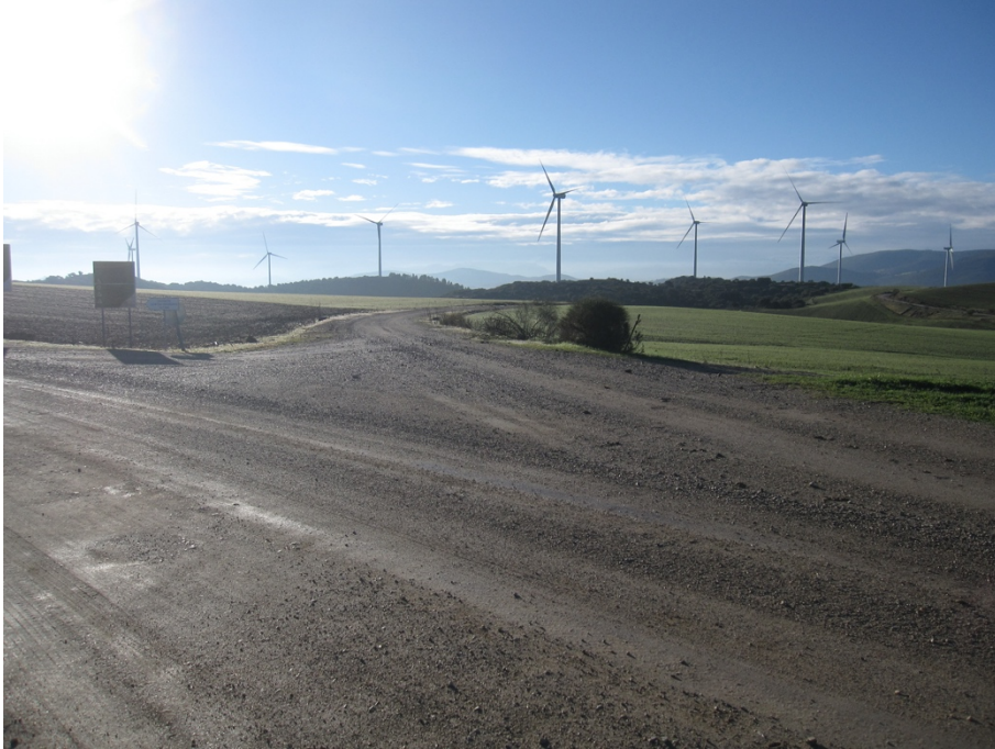
T2: Cruce del camino de la Dehesa con la Cañada Real de Almargen a Sierra de Yeguas
