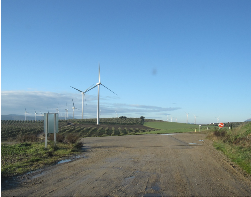
T2: Punto de cruce del camino con la carretera MA-6407
