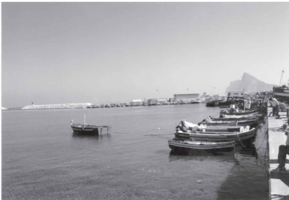
Vista desde las proximidades de la playa de varada hacia los muelles de ribera y contradique
