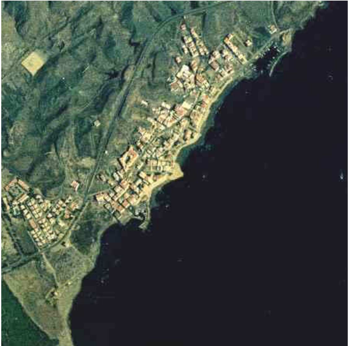
Instalaciones portuarias de Villaricos (1996)
