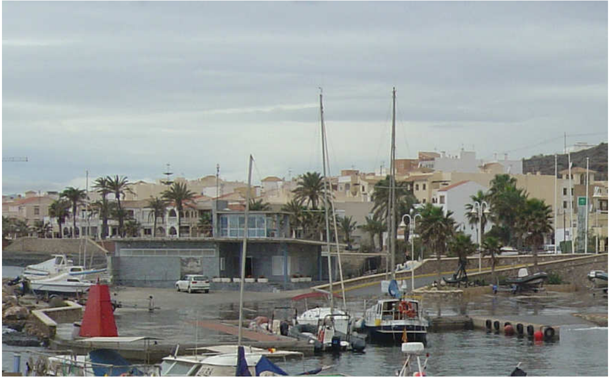
Vista del edificio administrativo y de aseos junto al acceso
