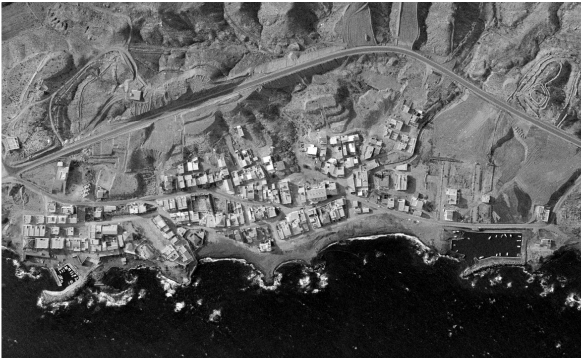
Instalaciones portuarias de Villaricos (1984)
