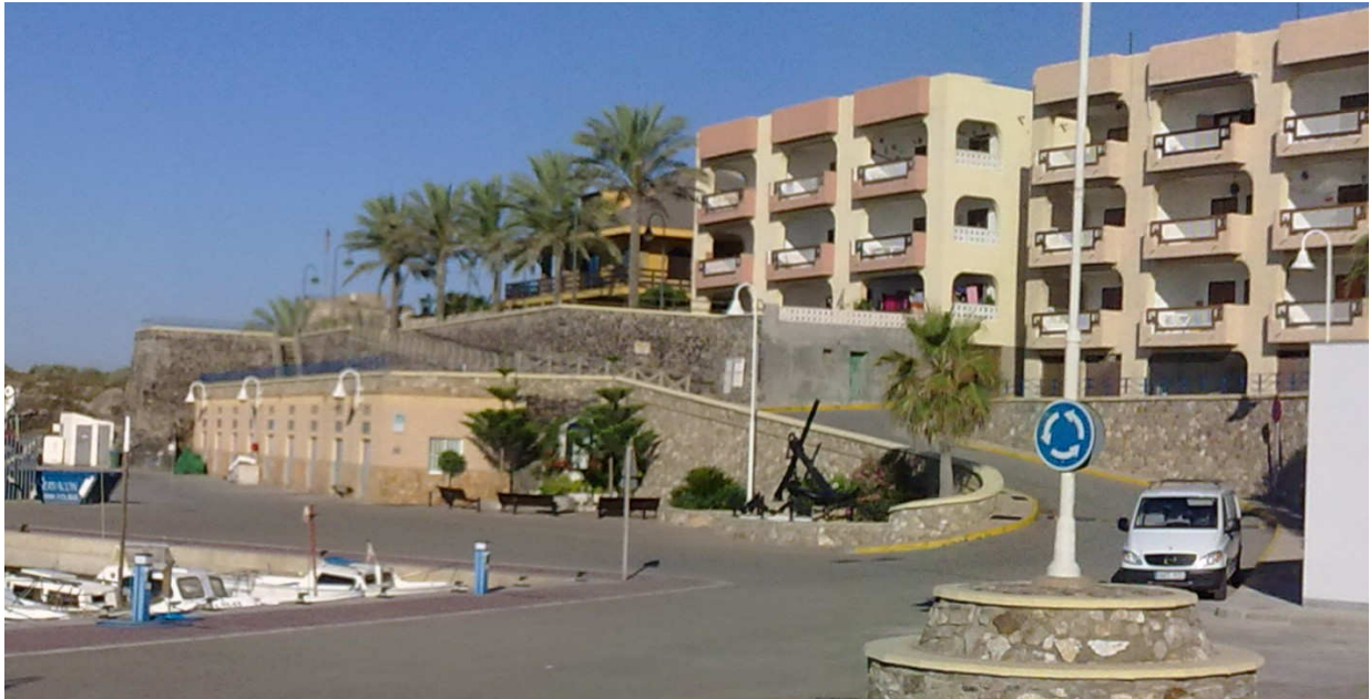
Vista del acceso al Puerto de La Balsa, con los cuartos de pertrechos al fondo
