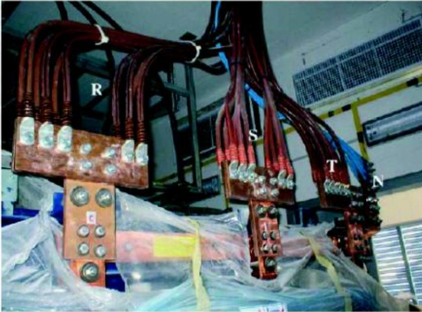
Figura 8.2 Ejemplo de alimentación en alta tensión [38]
