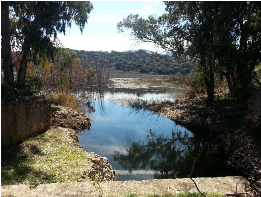
Entrada canal de desagüe de la Laguna Chica.
