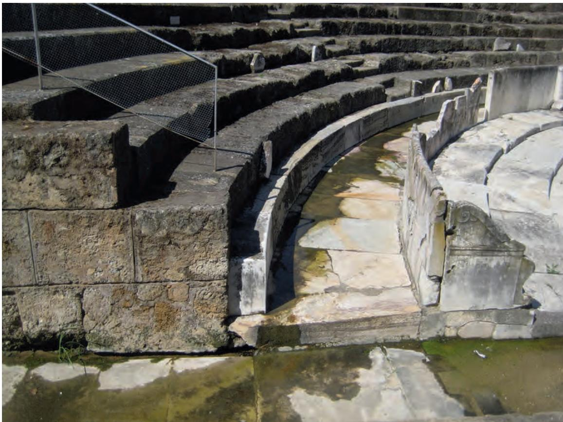
Fig. 1.- Filtraciones en la parte inferior del Teatro Romano de Itálica. Imagen tomada en abril de 2011.
