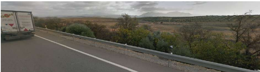
Ilustración 58: Vista hacia los terrenos de la explotación desde la carretera A-384 (sector occidental).
