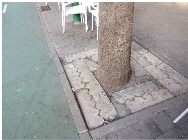
Imagen 1.5_36. Alcorque cubierto con losetas de hormigón.
