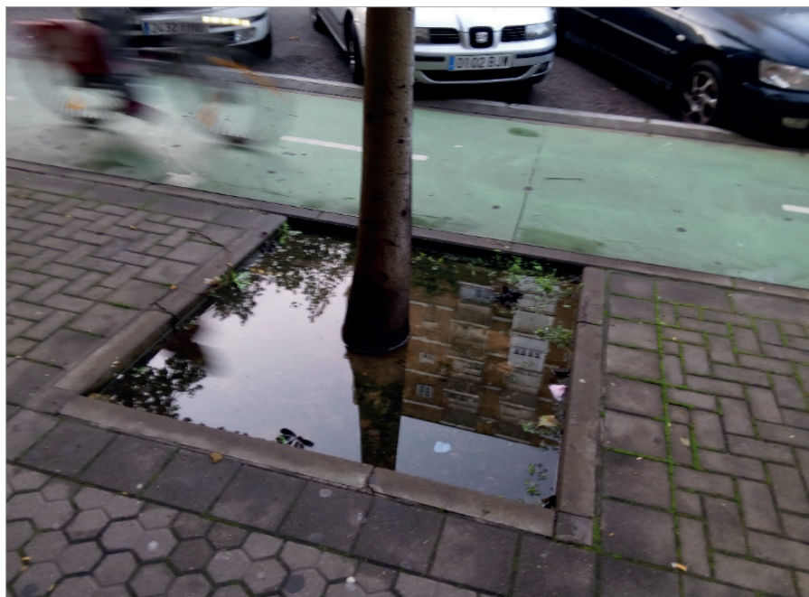
Imagen 1.5_3. Sustrato de alcorque con fuerte compactación que impide la penetración del agua de lluvia y de riego. La compactación también dificulta la aireación del sustrato.
