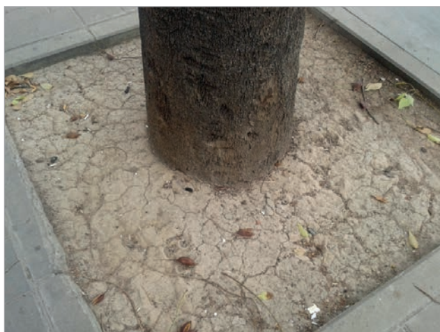
Imagen 1.5_1. Sustrato compactado que impide la correcta aireación del alcorque y la circulación del agua.
