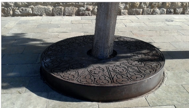
Imagen 1.5_33. Alcorque cubierto con una estructura metálica, si bien es posible el intercambio de aire y la circulación del agua, el propio alcorque constituye una barrera arquitectónica en el viario pavimentación.
