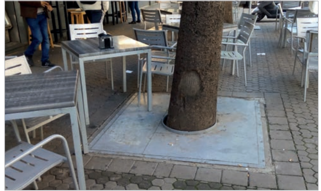
Imagen 1.5_42. Alcorque cubierto por una chapa metálica, estancia para el agua y el aire.
