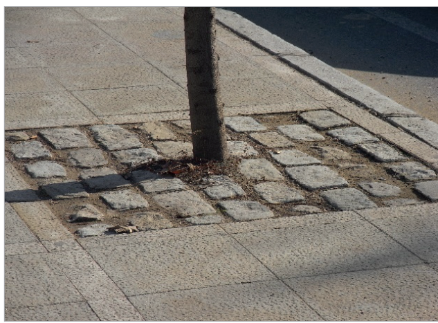
Imagen 1.5_38. Alcorque cubierto con adoquines.
