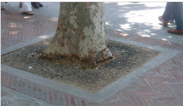
Imagen 1.5_43. Alcorque cubierto con una rejilla. Este sistema permite la libre circulación del agua y el aire, y es económico. Tiene el problema de la limpieza, por lo que habría que convencer a la ciudadanía que el alcorque no es una papelera de gran tamaño para tirar colillas y otros residuos, o para las deyecciones de los perros.
