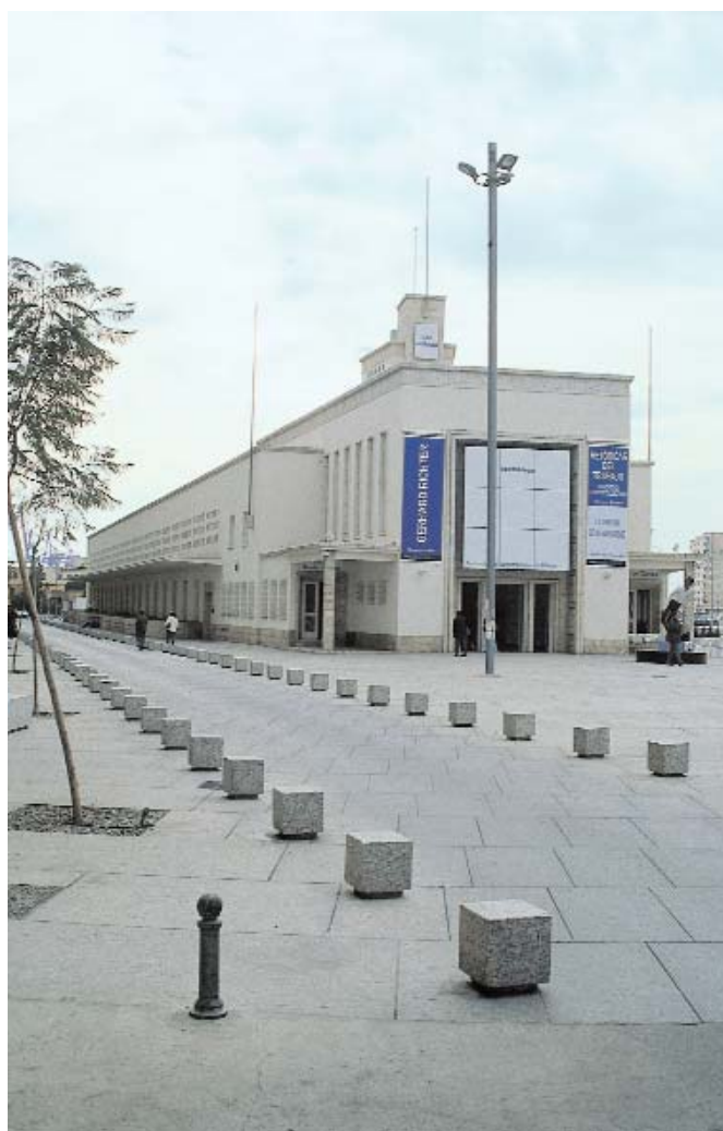
Fachada principal del CAC Málaga, antiguo acceso al Mercado de Mayoristas Foto del autor (2004)
