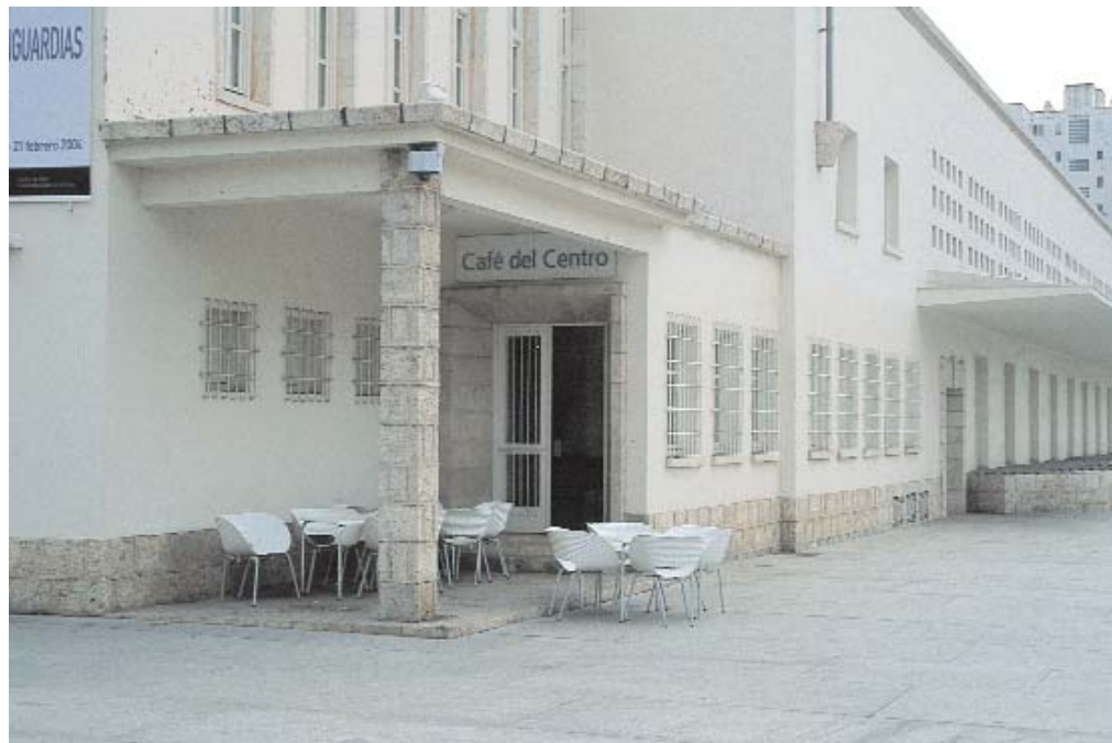
CAC Málaga, acceso y terraza cafetería-restaurante Foto del autor (2004)
