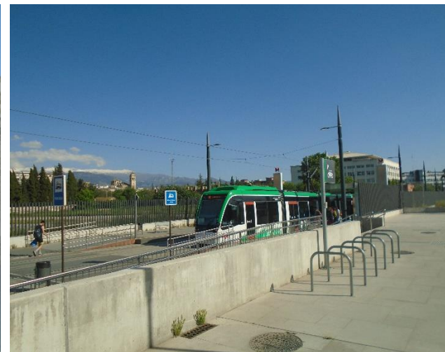
Imagen 9.103 Parada Metropolitano junto a estación de ferrocarril de Granada
