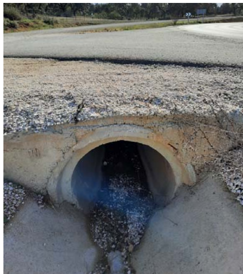
Foto 4.4.: Tubo obra de drenaje transversal al acceso
