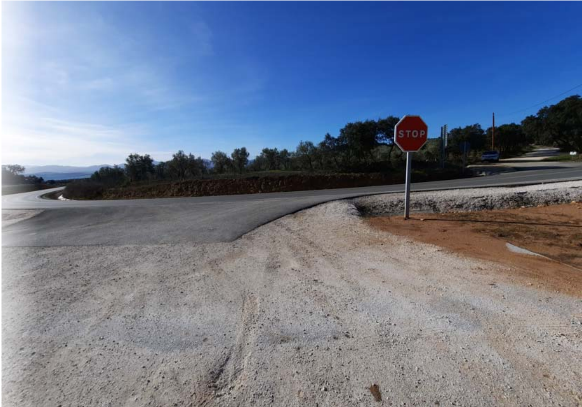
Foto 4.2.: Vista del acceso existente
