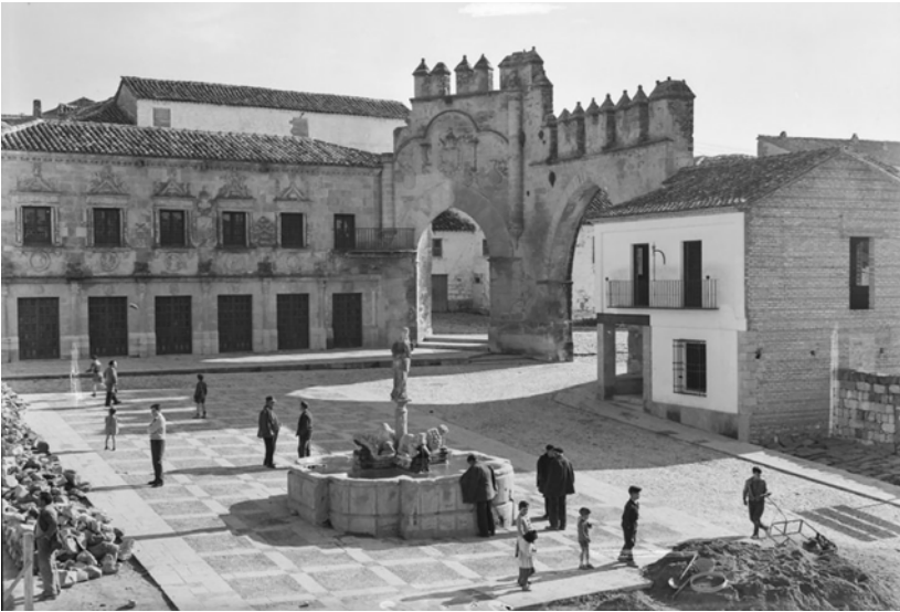
La plaza del Pópulo de Baeza durante las obras de implantación de las antiguas Carnicerías, que aparecen en la página siguiente. Fotos de J. M. Pando, 1964.
