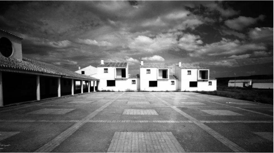
Poblado de colonización de Miraelrío, construido en 1964-1965 según proyecto de José Luis Fernández del Amo. Madrid, Archivo Fernández del Amo Arquitectos.
