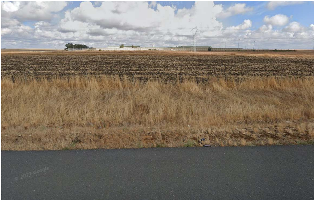
Ilustración 13: Vista de la planta desde la autovía A-49.
