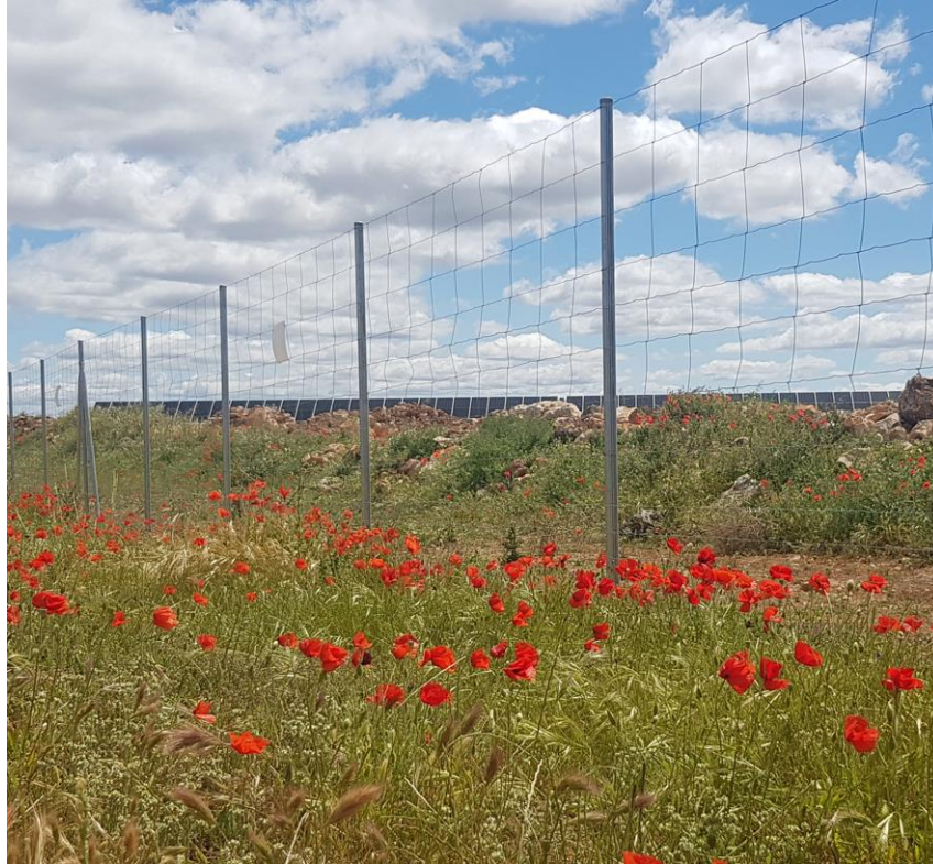
Figura 4.2.7.c. Vallado cinético para cierre perimetral. Fuente: Proyectos de Ejecución Planta Fotovoltaica Venta Angulo, Los Llanos y Las Canteras. T.M. Caniles (Granada).
