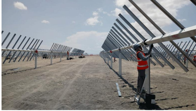
Figura 4.2.11.a. Montaje de estructura seguidor con perfiles hincados directamente en el terreno. Fuente: Proyectos de Ejecución Planta Fotovoltaica Venta Angulo, Los Llanos y Las Canteras. T.M. Caniles (Granada).
