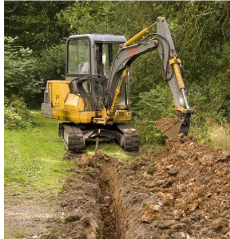
Figura 4.2.10.a. Excavación de zanjas. Fuente: Proyectos de Ejecución Planta Fotovoltaica Venta Angulo, Los Llanos y Las Canteras. T.M. Caniles (Granada).
