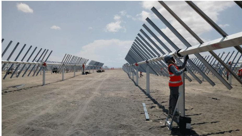
Imagen 41. Montaje de estructura seguidor con perfiles hincados directamente en el terreno
