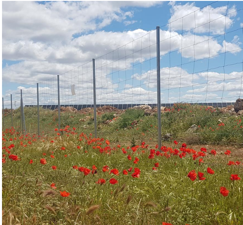
Imagen 38. Vallado cinegético para cierre perimetral
