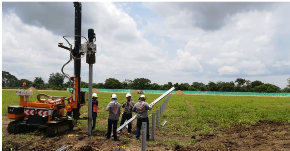
Imagen 39. Hincado de perfiles con maquinaria especializada
