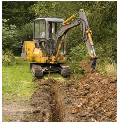
Imagen 40. Excavación de zanjas
