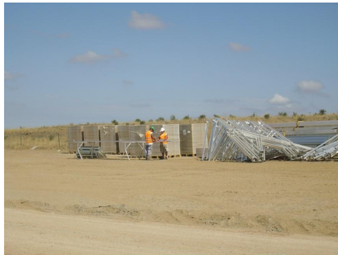
Imagen 35. Fotografía de instalaciones provisionales
