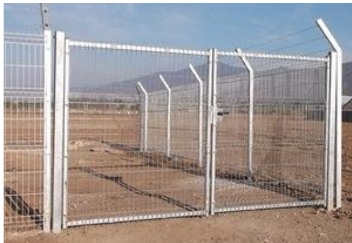
Imagen 37. Detalle de portón de dos hojas batientes tipo Acmafor
