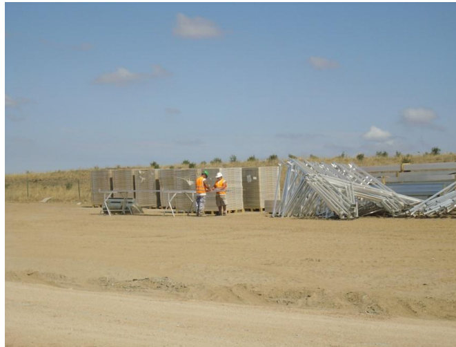
Imagen 35. Fotografía de instalaciones provisionales
