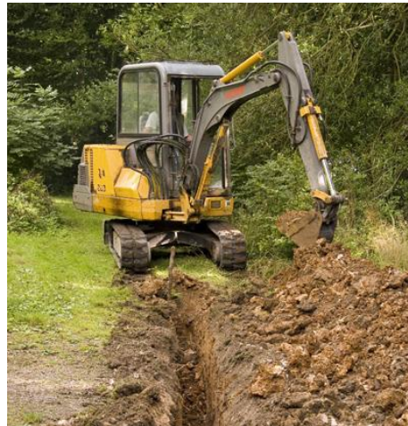
Imagen 40. Excavación de zanjas
