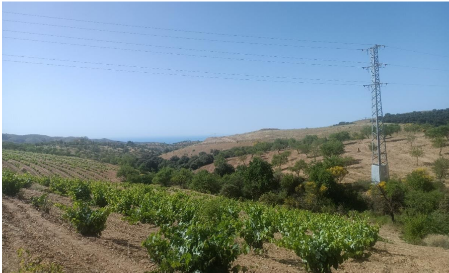
Fotografía 10. Apoyo de anclaje de la nueva línea en el extremo N de ésta. Paisaje hacia el S.
