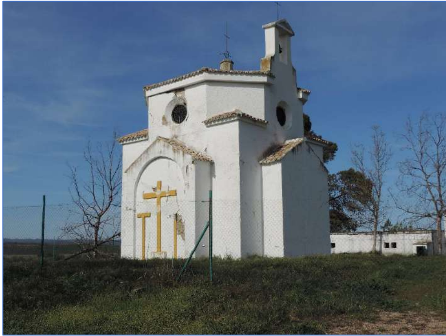
Figura 10. Edificación. Fuente: propia.
