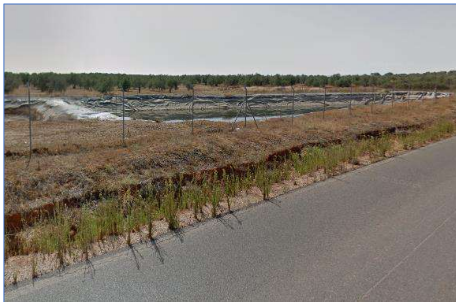
Figura 28. Balsa de riego. Fuente: propia.
