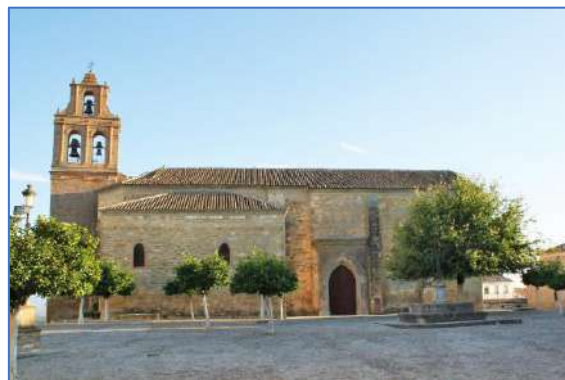
Figura 68. Iglesia de Santa María. Fuente: http://andalucía.org
