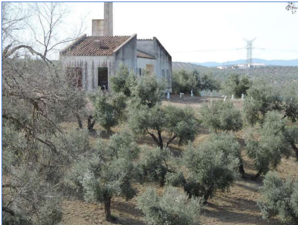
Figura 11. Edificación. Fuente: propia.
