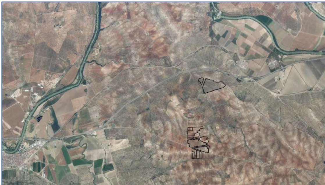
Figura 48. Planta fotovoltaica sobre ortofoto. Fuente propia
