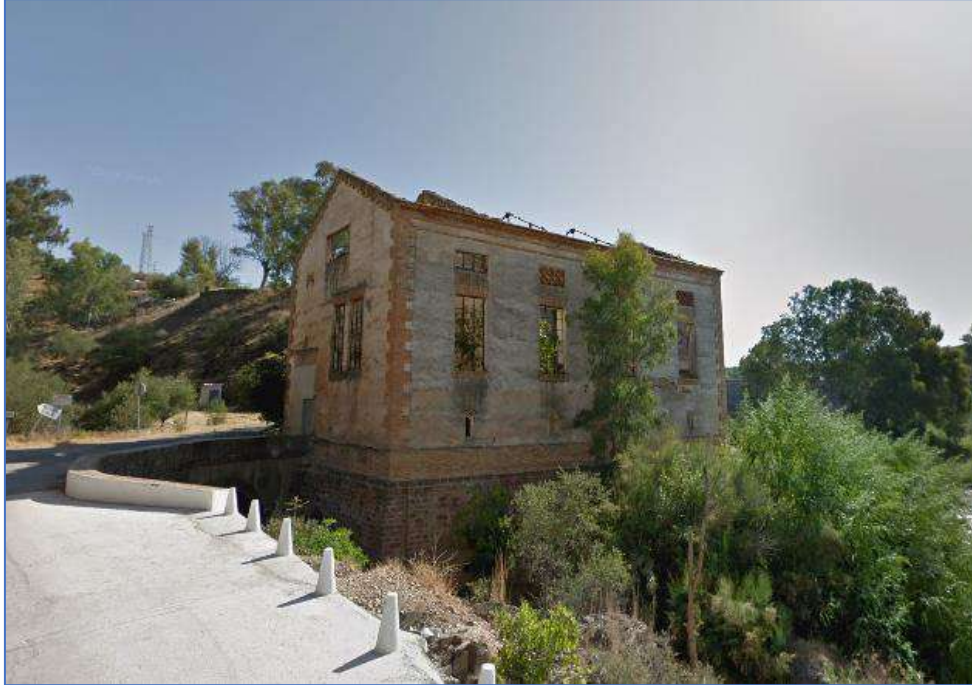
Figura 10. Edificación abandonada. Fuente: propia.
