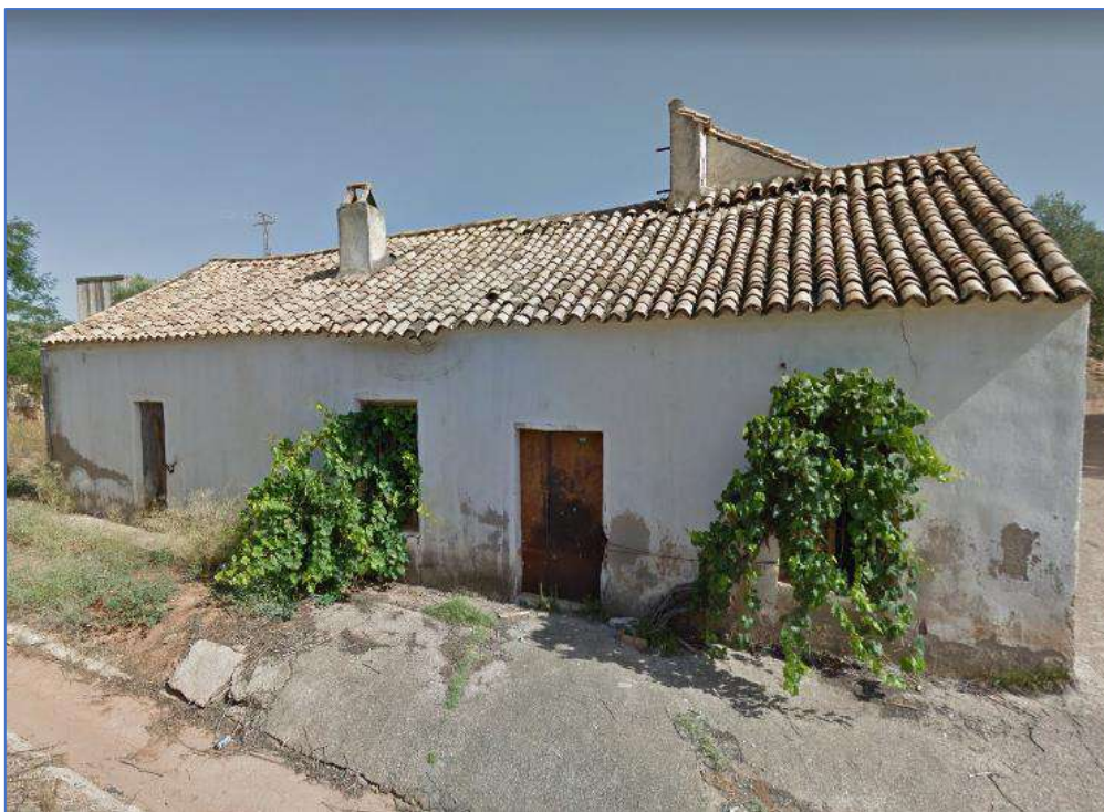
Figura 11. Edificación semi-abandonada. Fuente: propia.
