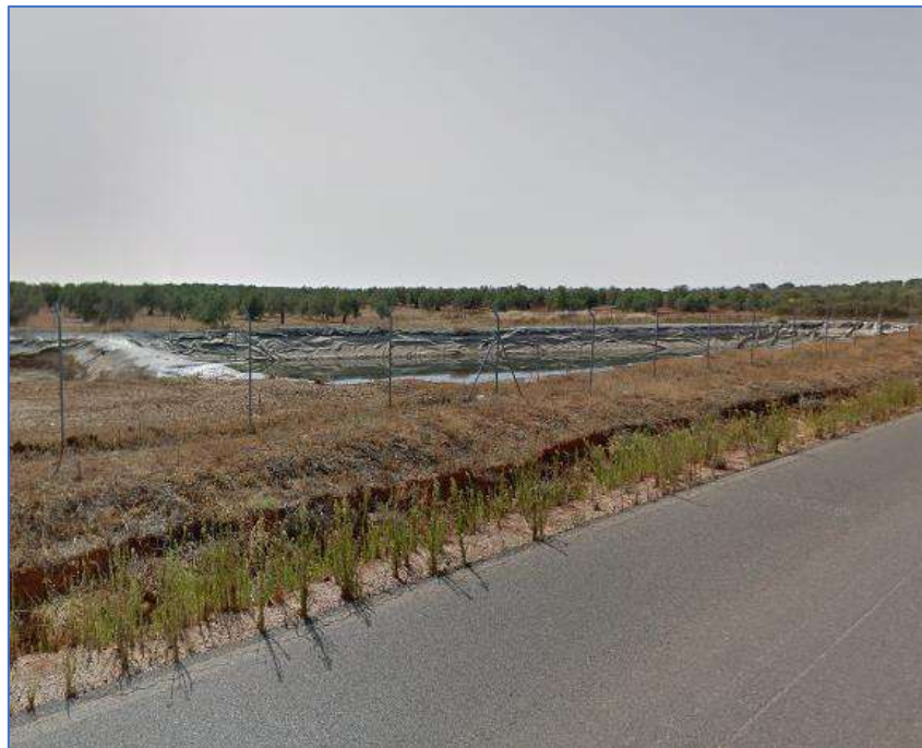
Figura 28. Balsa de riego. Fuente: propia.
