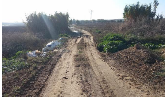
Obra de drenaje ø600 en PK 0+900
