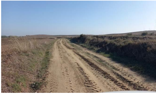
CAMINO NORTE en pk 0+900 a 1+100, coincidente con Vereda de los Carboneros
