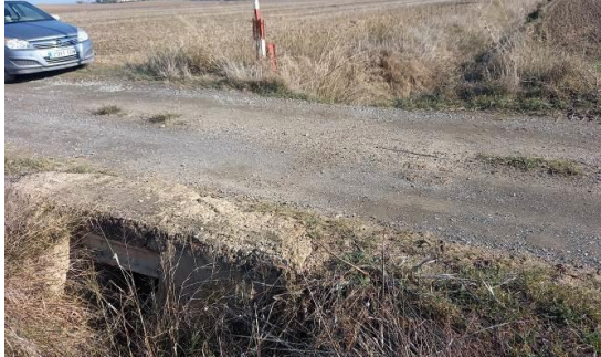
Obra de drenaje tajea 80x80 cm en PK 0+320
