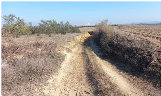
CAMINO NORTE en pk 2+060, en trinchera
