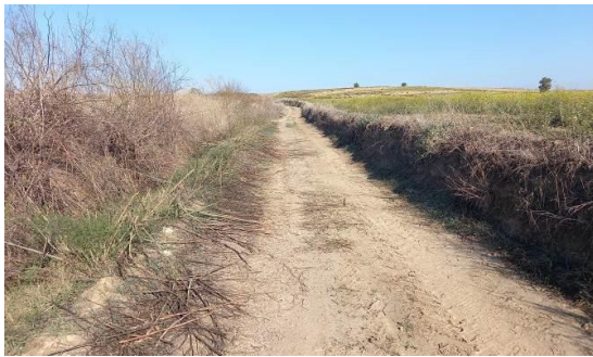
CAMINO NORTE en pk 1+640, en trinchera
