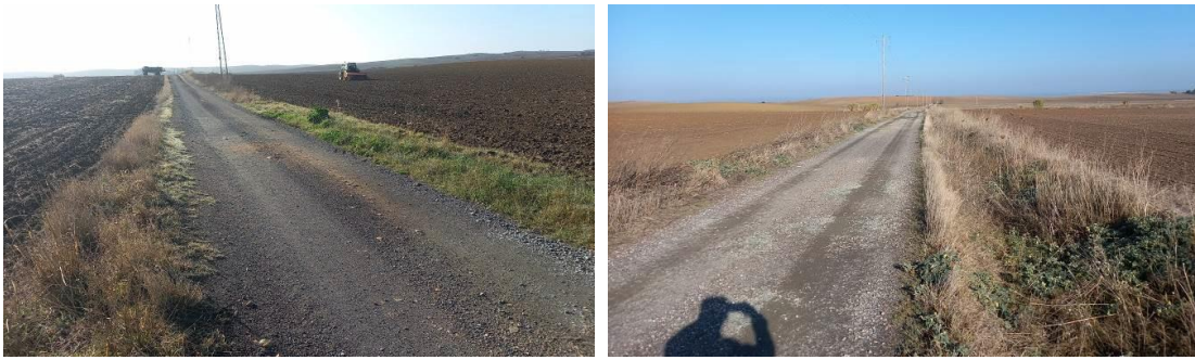
Camino existente en primer tramo del CAMINO SUR
