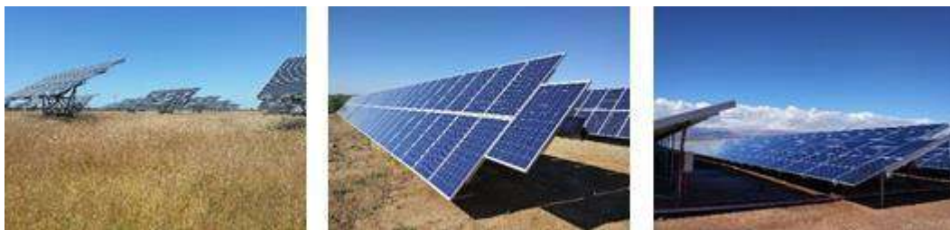
Tipos de estructura fotovoltaica. (a) Seguidor a dos ejes. (b) Seguidor a un eje (horizontal). (c) Fija.
