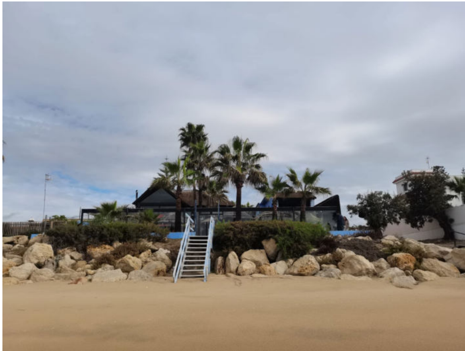
ESTADO ACTUAL TALUD.
