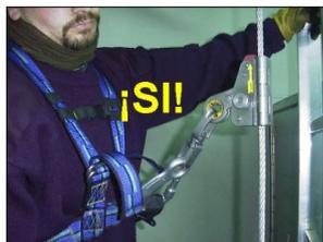
Las anillas laterales no están diseñadas para la protección anticaídas. Su uso está indicado para anclarse a una estructura y poder disponer de ambas manos para realizar una labor.
