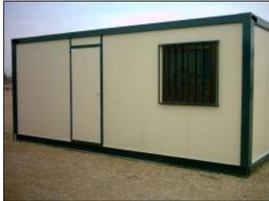
*Imagen 16 Contenedor prefabricado para instalaciones provisionales de obra.*
