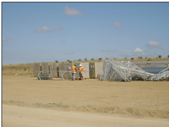
Imagen 16 Fotografía de instalaciones provisionales.
