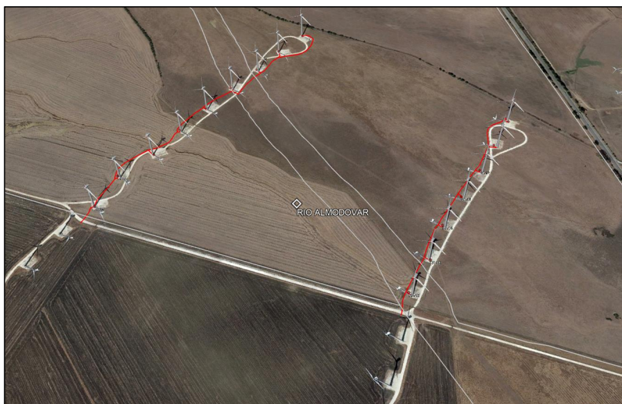
Imagen 12 Configuración de zanjas previa a 20 kV.
