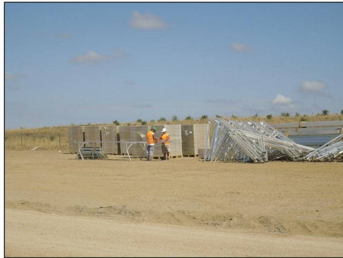
Imagen 17 Fotografía de instalaciones provisionales.
