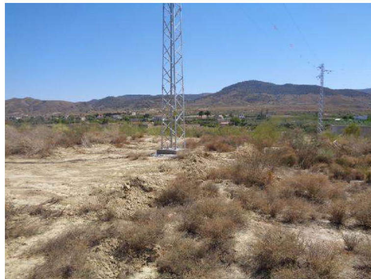
Foto 50: Sector DP 02, línea eléctrica situada en el ámbito de estudio.
