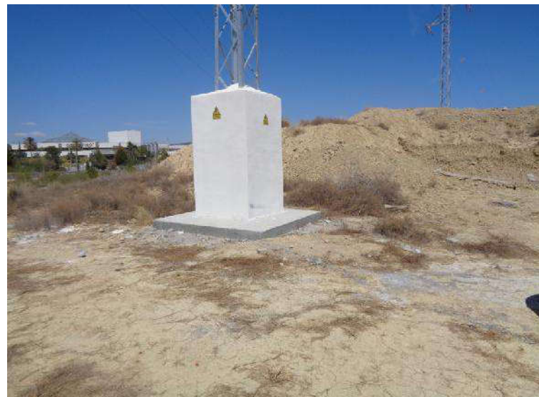
Foto 38: Sector DP 02, apoyo de línea eléctrica instalado recientemente en la zona norte.
