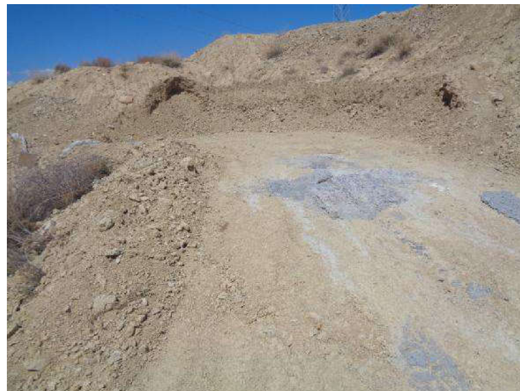
Foto 42: Terrenos explanados para la construcción de una línea eléctrica en la zona norte.
