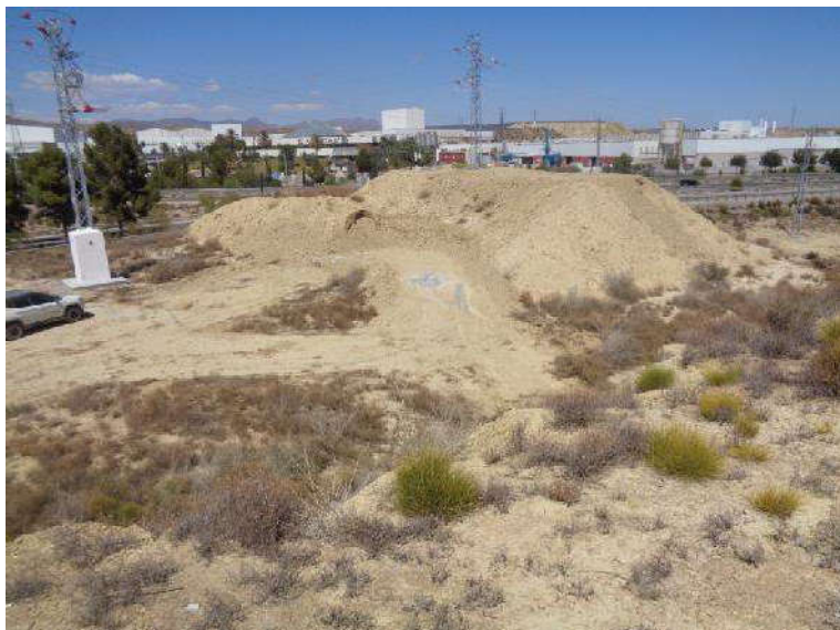
Foto 45: Sector DP 02, remociones del terreno realizadas en la zona norte para la construcción de una línea eléctrica.
