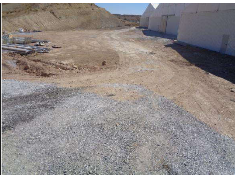
Foto 51: Sector DC 01 (parcelas de dotación colectiva), terrenos rebajados junto a las naves del Parque Industrial.
