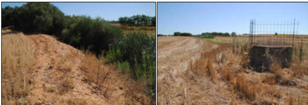
DETALLE DEL CAUCE DEL ARROYO Y DETALLE DE POZO EN USO CON ESTRUCTURA DE RECIENTE CONSTRUCCIÓN.
