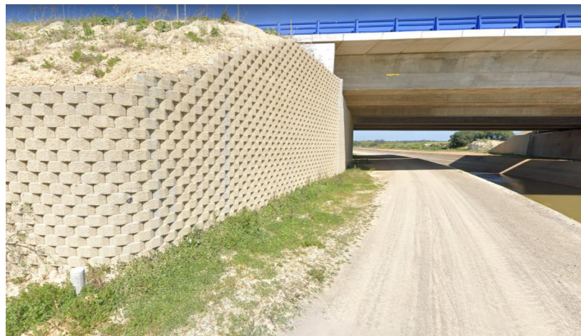
Imagen 2. Paso subterráneo de la circunvalación SE-40
