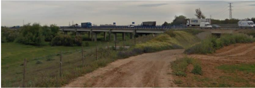
Imagen 6. Paso elevado de la Autopista del Sur (A-4) sobre el Río Guadaira
