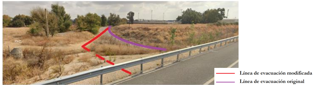
Imagen 4. Paso subterráneo de la Autovía del Sur
