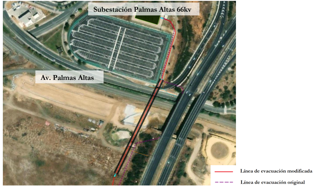
Imagen 8. Cruce de Servicios y Conexión
