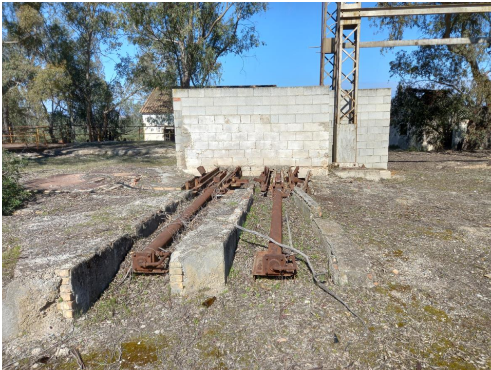
Figura 5. Protección de pozo minero existente. Fuente: Kerogen Energy.
