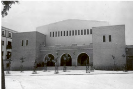
Fachada del mercado, en las fechas cercanas a su construcción.
