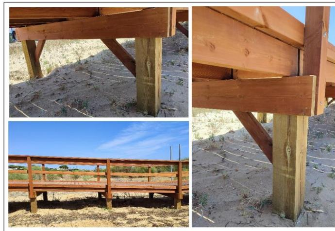
**Ilustración 6.** Detalles constructivos de la pasarela tipo.
