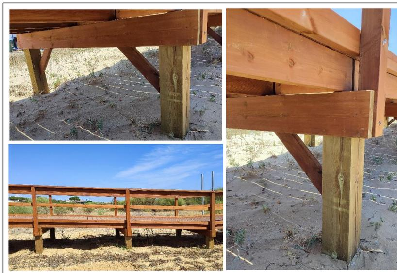
**Ilustración 22.** Detalles constructivos de la pasarela tipo.
