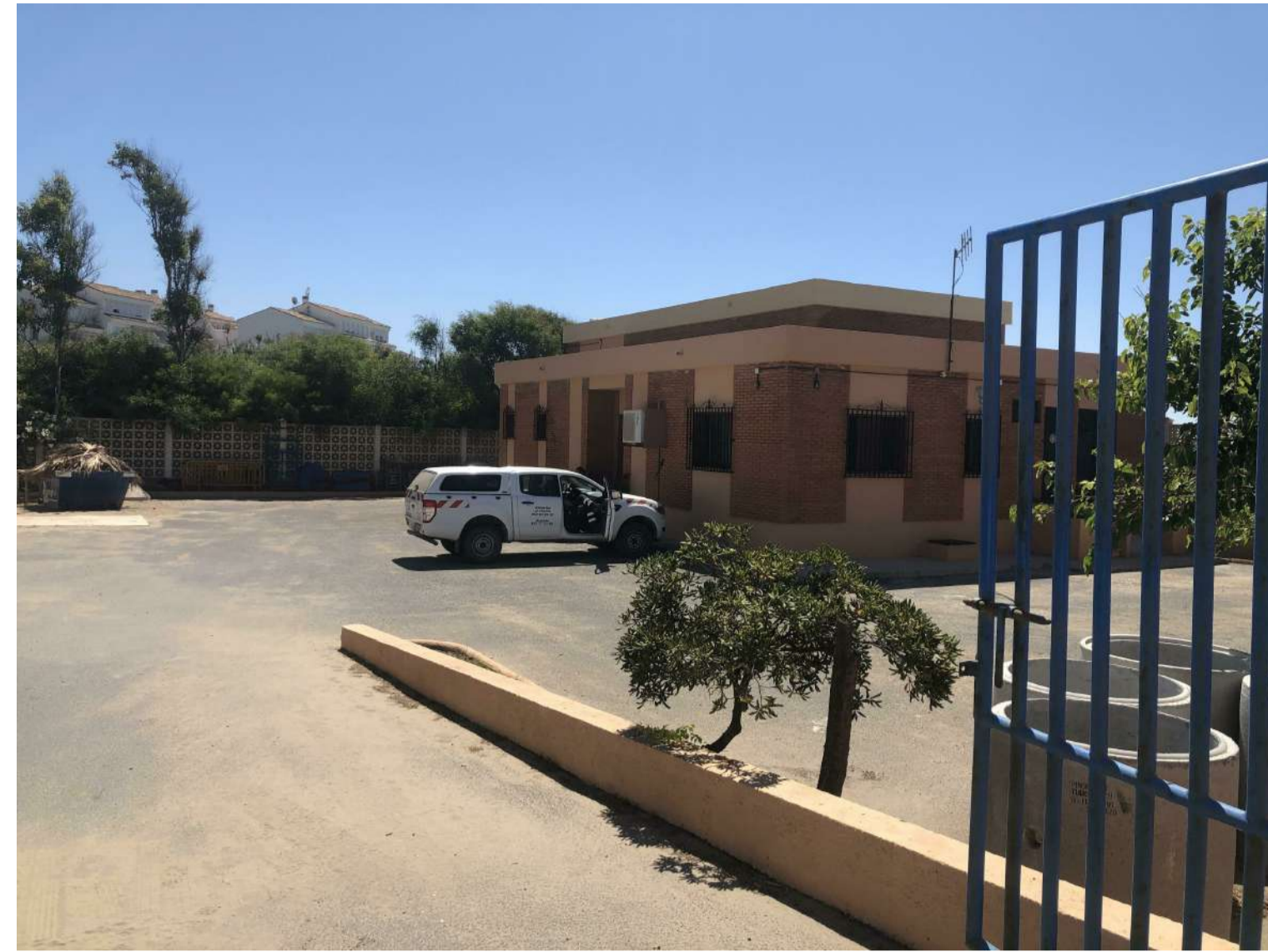
Estación de bombeo de Acosol propuesto para demoler y reubicar en parcela cercana, fuera de la playa (02)
