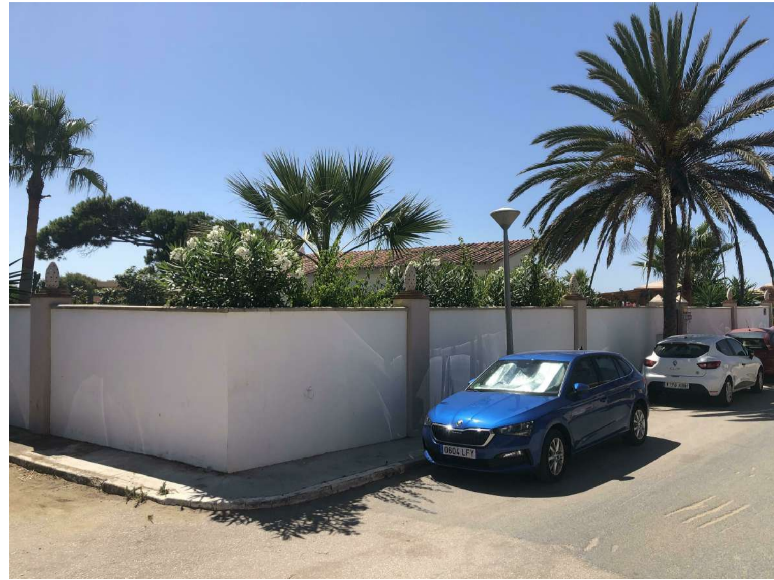
Cerramiento Chalé a demoler (01)
