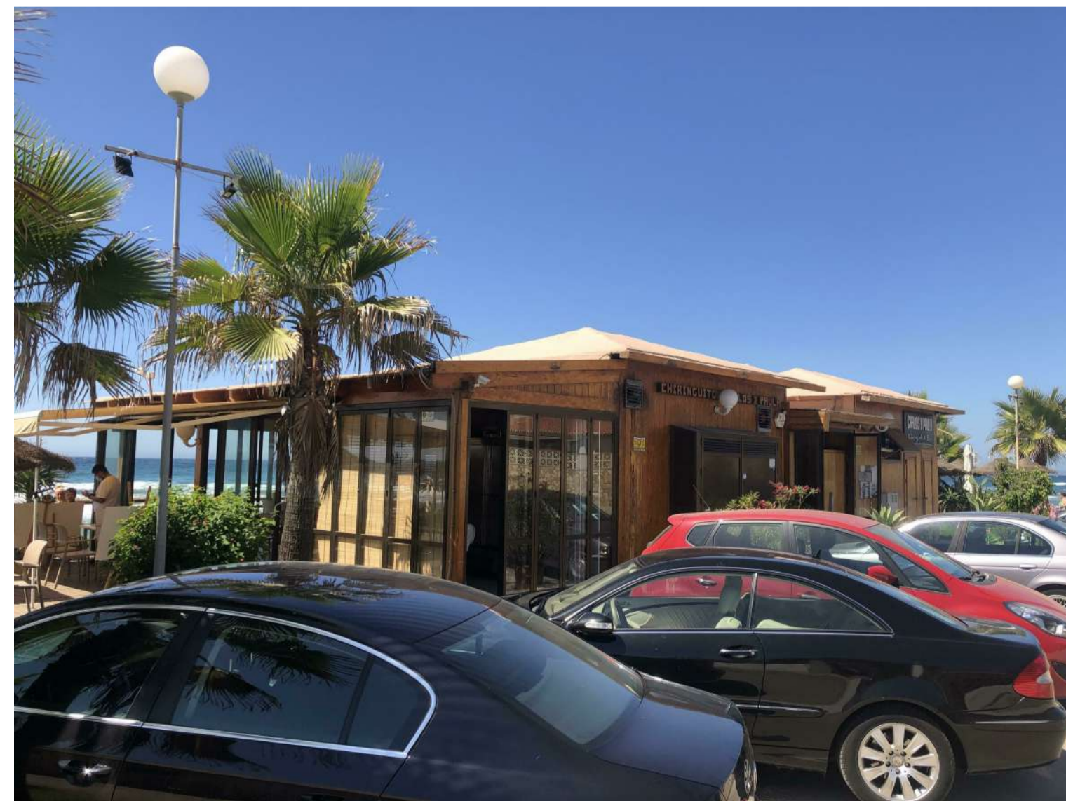
Chiringuito a demoler (03)
