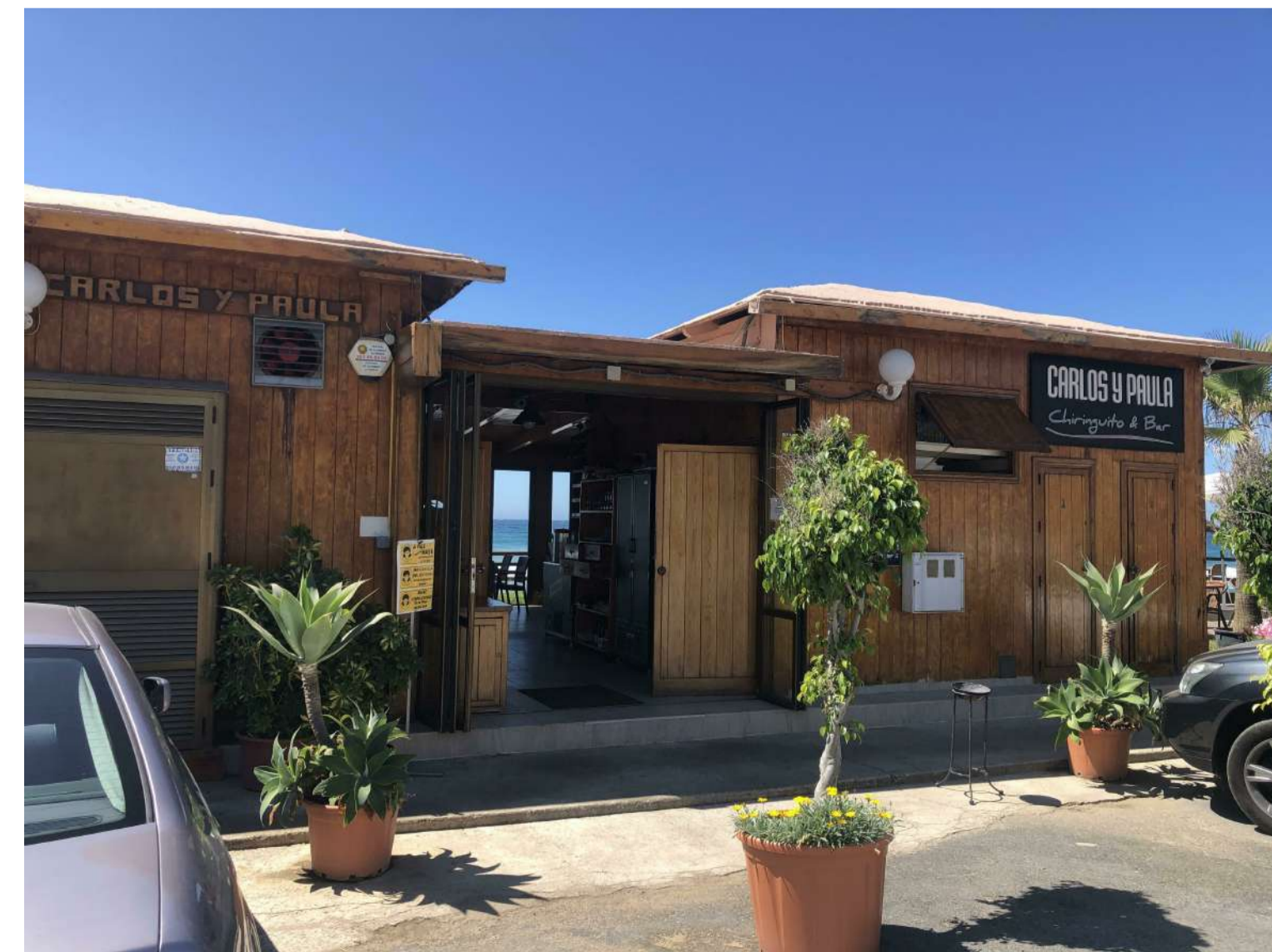
Chiringuito a demoler (03)
