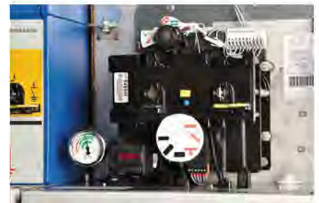
Ejemplo de mecanismo de maniobra BR
