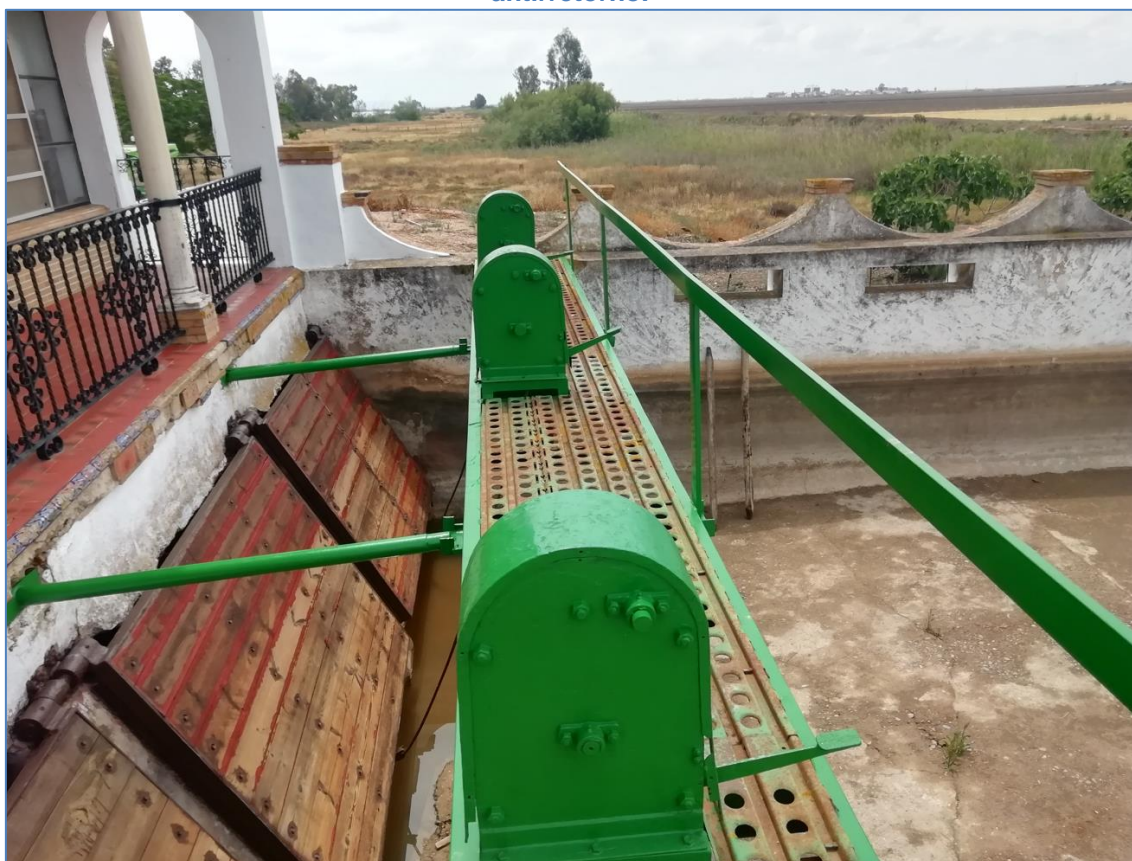
Figura 19. Pasarela en canal de riego con el accionamiento manual de las compuertas antirretorno.
