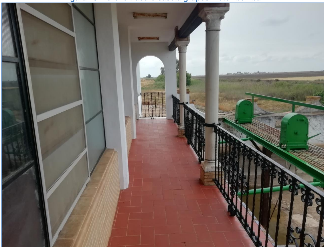
Figura 19. Pasarela en canal de riego con el accionamiento manual de las compuertas antirretorno.
