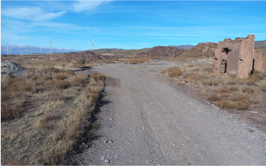
Figura 10. Movimientos de tierra y edificios abandonados asociados a la explotación minera.
