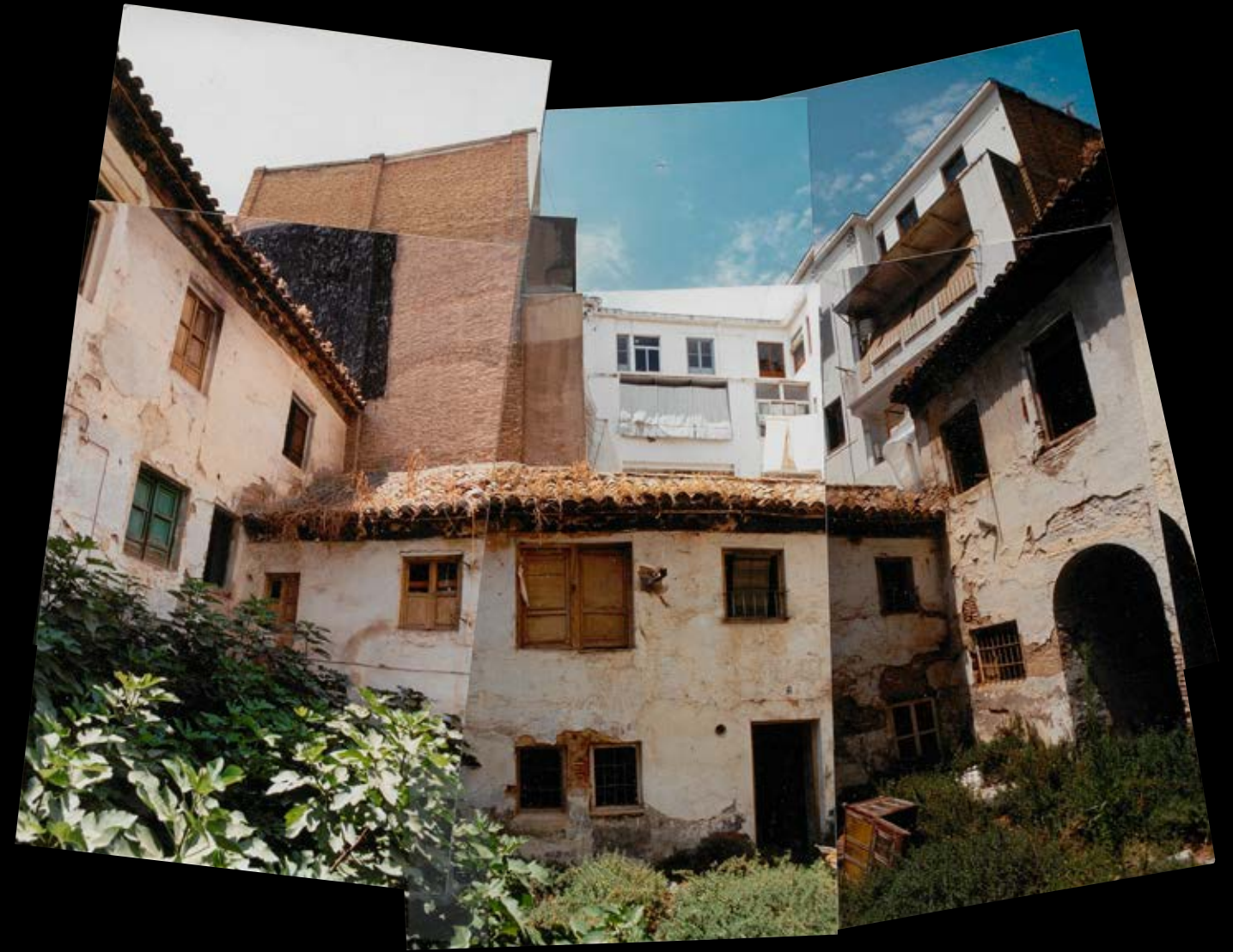
Fotomontaje de la antigua casa ollería del siglo XVI en la calle Jarrería n.º 7 y 9, antes de su demolición, en 1997 [Archivo Histórico Provincial de Granada, C-13871-5]
